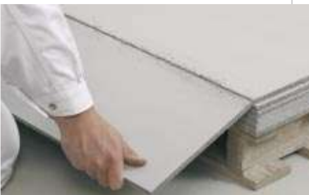
Warstwę wierzchnią przeciąć nożem do tapet...
