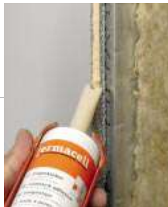
Appliquer la colle à joint FERMACELL au centre du bord de la planche.
