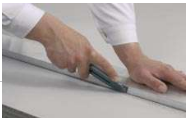
Warstwę wierzchnią przeciąć nożem do tapet...
