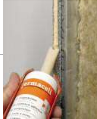
FERMACELL Fugenkleber mittig auf die Plattenkante auftragen.
