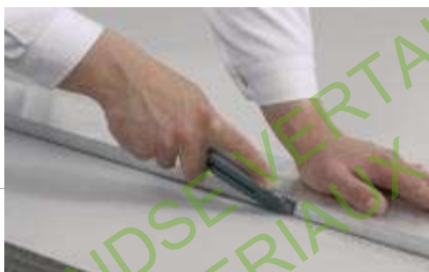
Snij de bovenste laag met een behangmesje...
