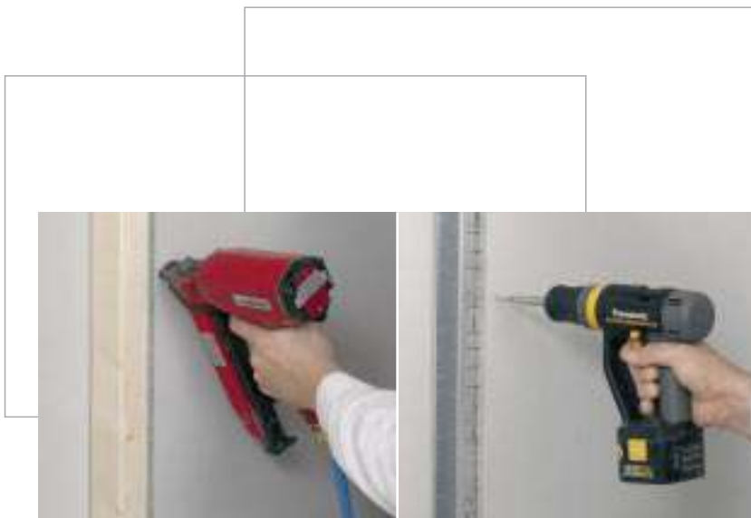
Bevestig het bord met klemmen of schroeven aan de draagconstructie
