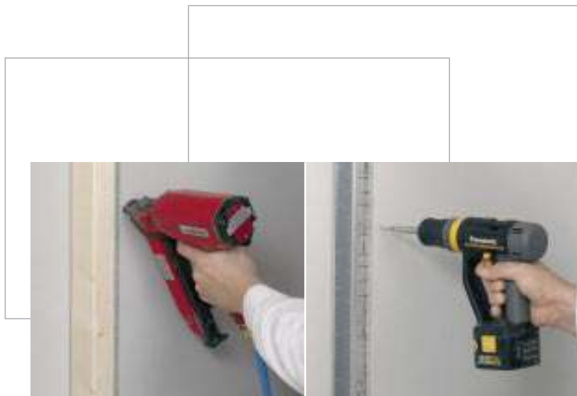
Klamrami lub wkrętami przymocować płytę do konstrukcji nośnej
