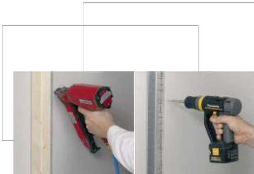
Fixez la planche à la structure de support avec des pinces ou des vis
