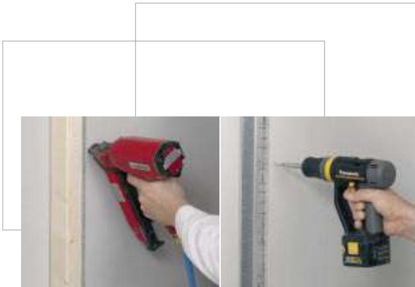
Befestigen Sie das Brett mit Klammern oder Schrauben an der Trägerstruktur
