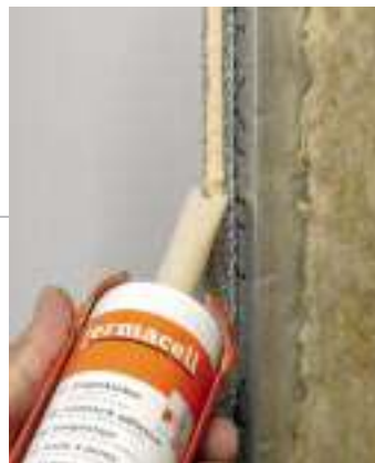
Klej do spoin FERMACELL nanieść na środek krawędzi płyty
